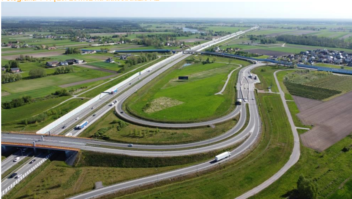
Fotografia 1 Węzeł Łowicz na autostradzie A2
